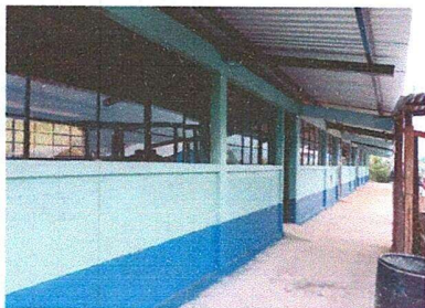
Foto 5: TECHO NUEVO REABILITADO
