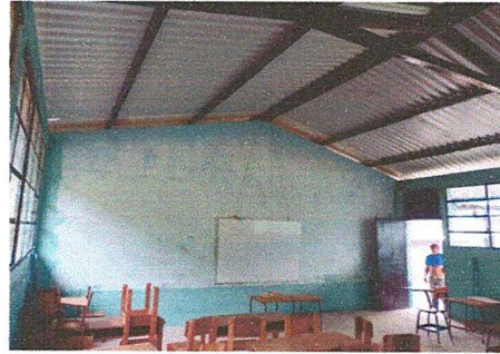
Foto 2: VISTA PREVIA TECHO TRABAJADO
